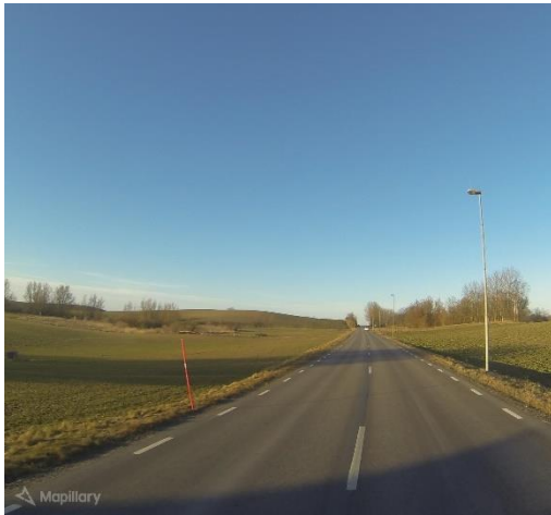
Figur 4.9 (till vänster) Klass B3, en 70-väg på landsbygden med en medeldygnstrafik på 1000-2000 fordon per dygn. Figur 4.10 (till höger) Klass B3, högt trafikerad väg i tätort. Foto: Mapillary
