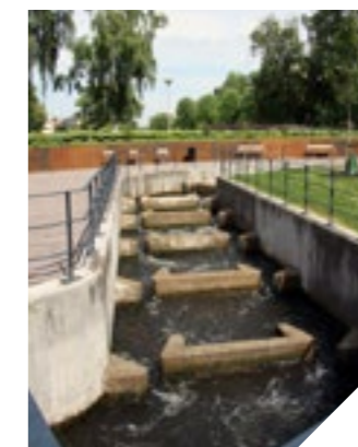
Bild: Vattenlek i Strömparken.
