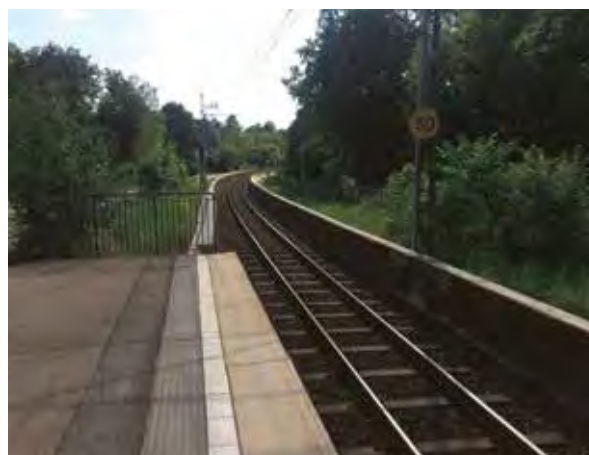
Lågt bullerskydd nära spåren, Roslagsbanan.
