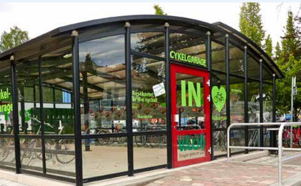
Cykelgarage vid resecentrum i Växjö. Foto: Växjö kommun
