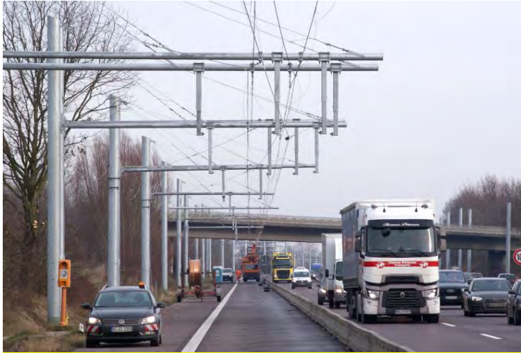
Figur 48. System under byggnation i Tyskland ( https://www.ehighway-sh.de/de/baugeschehen.html )
