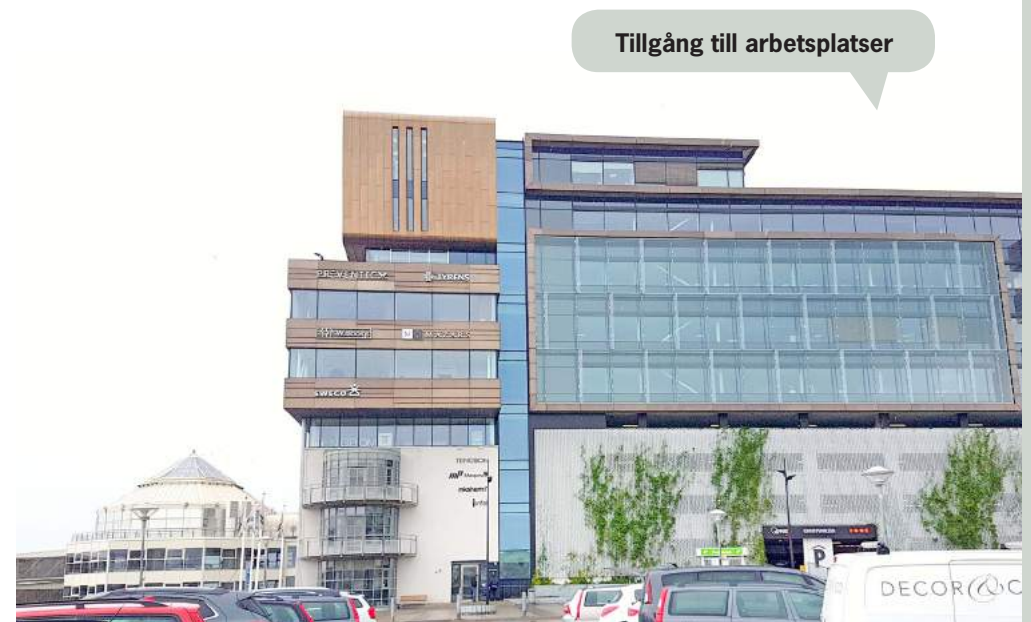
Bild 31. Kontorsbyggnad i Helsingborg
